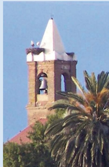
Torre de la Iglesia de San Pedro / R. Molina
